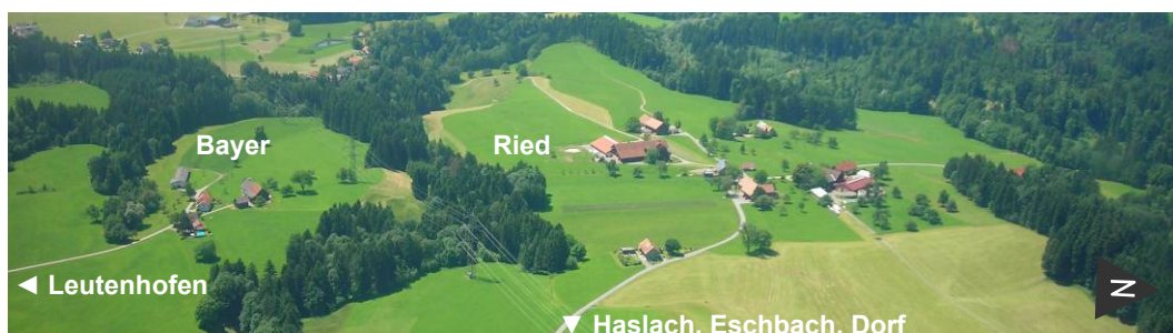
Blick Richtung Ried vom Dorf aus in Süd-West-Richtung
